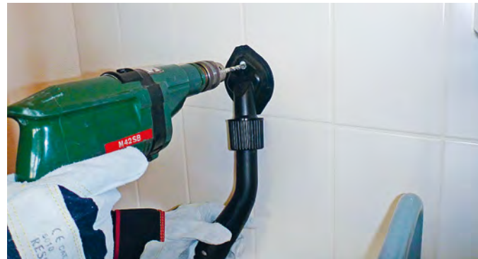
Perçage d'un carreau
