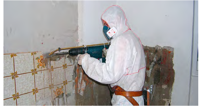
Enlever les carreaux par voie humide (< 5 m 2 )
