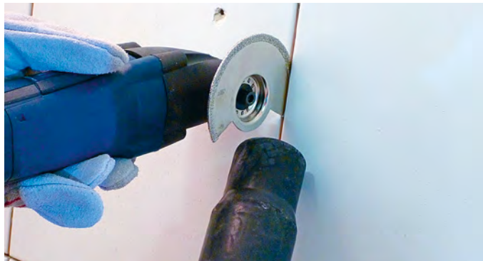
Remplacement d'un carreau
