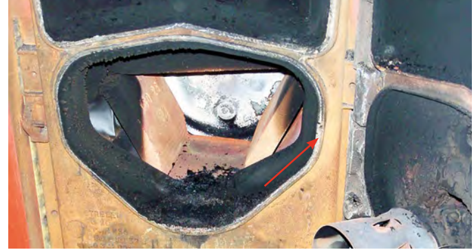
Cordon en amiante servant de joint
