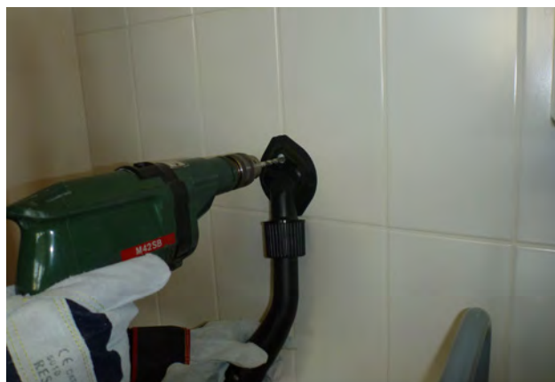
4 Perceuse avec aspiration à la source pour les carreaux en céramique comportant de la colle amiantée.
