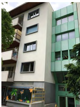
Façade NE (adossé à l'immeuble voisin)
